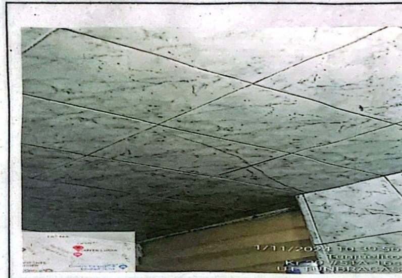
Foto No. 2 Descripción: Fisuras en baldosa del techo
